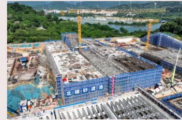
10月9日，继天健一建沙湾二水厂项目北侧清水池封顶83天后，项目扩建工程北侧砂滤、活性炭滤、臭氧组合池顺利完成封顶。此次封顶的北侧综合池单座规模达25万立方米/天，其中包含V型砂滤池、后臭氧接触池、炭滤池和叠合清水池，砂滤、活性炭滤、臭氧组合池总规模达50万立方米/天。北侧综合池是项目第二大单体构筑物，顺利封顶标志着项目施工取得了重要的阶段性胜利。项目各参建单位现场管理人员共同见证了封顶时刻。
